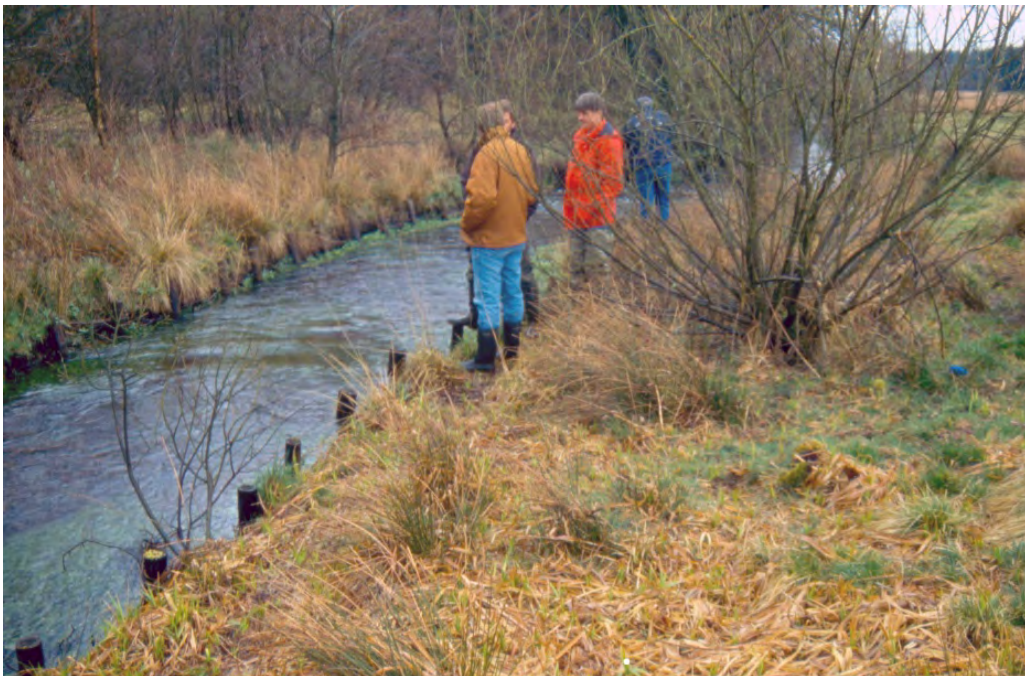
Figur 146. Ett parti av Gudenån i Danmark har smalnats av 1,5 m genom att påla i fåran och sedan fylla igen innanför. På bilderna syns att det avsmalnade avsnittet har högre vattenhastighet än nedanförliggande bredare partier. Detta har gjort att man kunnat anlägga lekområden på platsen och också erhållit reproduktion av öring. Idealt hade man nog gjort avsmalningen mer naturlig och gett vattnet större möjlighet att nå svämplanet. Foto: Erik Degerman.
