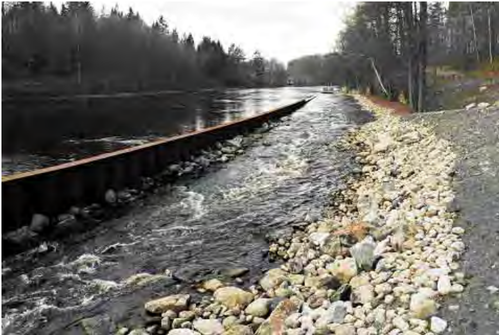
Figur 121. Hemsjö övre fiskväg anlagd som ett inlöp parallellt med Mörrumsån. Stålspont har körts ned i botten, se Larssenspont som används i hamnar. Faunapassagen fungerar också som extra utlopp vid högflöden då vattnet rinner över skiljeväggen. I ett så här stort vattendrag bör man även beakta möjligheten för kanotsport. Kanske genom att göra en passage genom spontningen i den uppströms delen. Foto: Erik Degerman.
