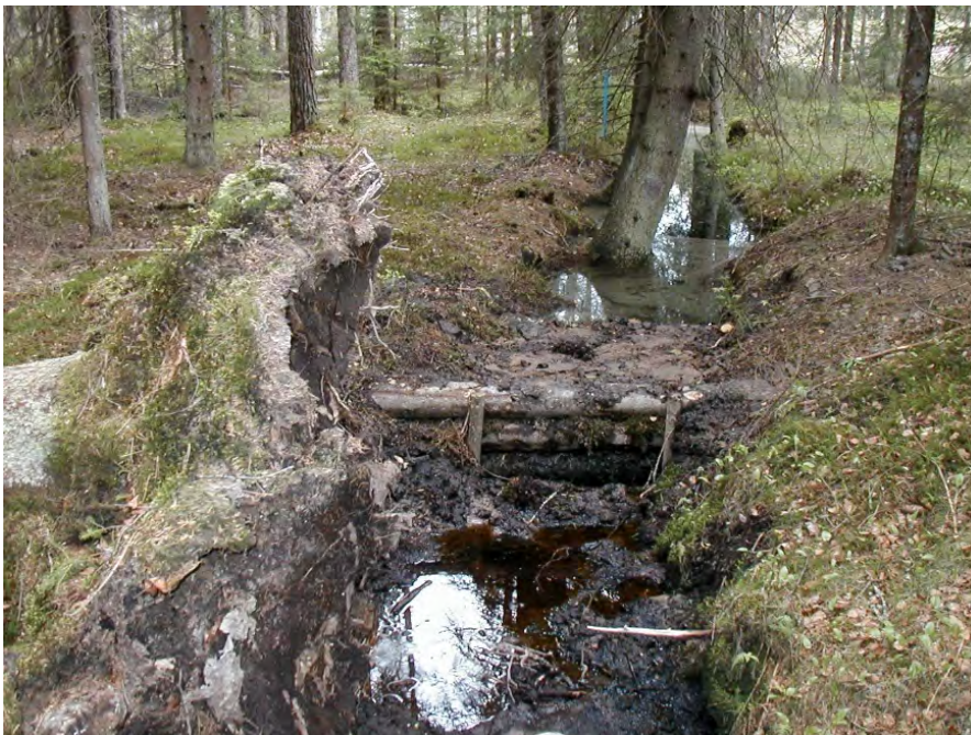
Figur 63. Enkel dikespropp vid rotvälta. Proppen är gjord av massaved och bottenstrukt från diket. En tätning med geotextil, eller hellre lämpligt naturmaterial, gör proppen tät. Livslängden på en sådan propp kan dock vara relativt kortvarig. Foto: Lennart Henrikson.
