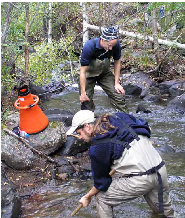
Figur 170. Etablering av lekbotten enligt Hartijoki-metoden. Uppströms grävs och sållas lekgrus fram och läggs sedan precis nedom forsacken nedströms. Vid forsacken har ett antal större stenar/block lagts för att hålla kvar lekgruset. Joel i bakgrunden står på dessa stenar/block. Foto: Erik Degerman.
