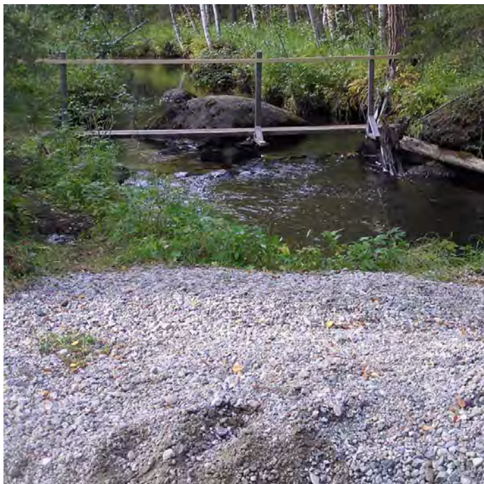
Figur 173. Lekgrus framkört med dumper färdig att läggas ut i Tuggenbäcken, Västerbotten, för hand. Lekgruset lades nedströms den stora stenen mitt i vattendraget (se nästa bild) och kommer därför att ligga kvar vid högflöden. Genom viss styrning av vattenströmmen med stenar (se nästa bild) erhålls tillräcklig vattenhastighet över substratet. I bäcken fanns flodpärlmussla som flyttades undan tillfälligt vid lekgrusutläggning för att ej störas. Foto: Erik Degerman.
