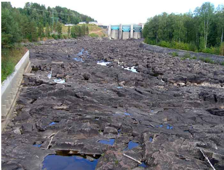
Figur 101. Torrfåra nedom Lasele kraftverk i Ångermanälven. Foto: Erik Degerman.
