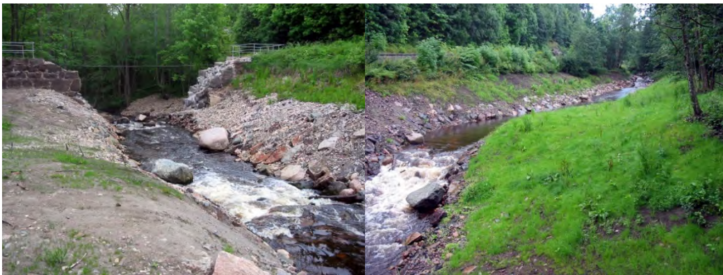
Figur 109. Hökhultsdammen efter utrivning. Efter utrivning blev 1 km ytterligare av Tabergså tillgänglig för vandrande fisk, till exempel insjööring från Vättern. Tätheten av öring har ökat från 5,2 per 100 m 2 till 140 per 100 m 2 två år efter åtgärd. Notera hur stränderna stenklätts för att minimera erosion. Genom stentläggning i fåran har variation och mindre forsnackar erhållits. Foto: Per Sjöstrand, Jönköpings Fiskeribiologi AB.
