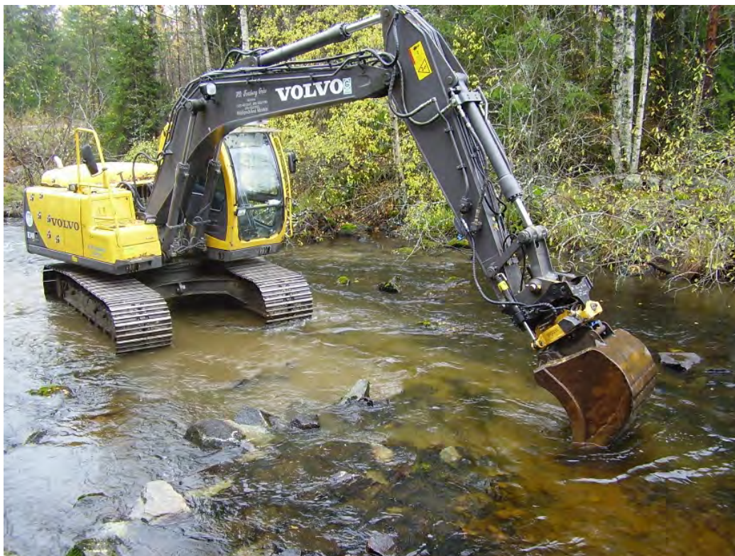
Figur 155. Här har man med grävmaskin grävt en meandrad djupfåra i ett moränvattendrag, Skärjån, så att det håller vatten och tillåter fiskvandring under lågvattenperioder. Foto: Jan Lundstedt, f.d. Söderhamns kommun.
