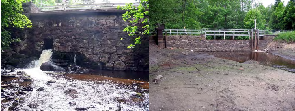
Figur 108. Hökhultsdammen i Tabergså, Jönköpings län, före utrivning. Dammen var 5 m hög och 350 m lång. Den tömdes så att inte sedimentet rubbades. Sedimentet var förorenat och den bästa lösningen var att låta det ligga kvar, men täckas över. Foto: Per Sjöstrand, Jönköpings Fiskeribiologi AB.
