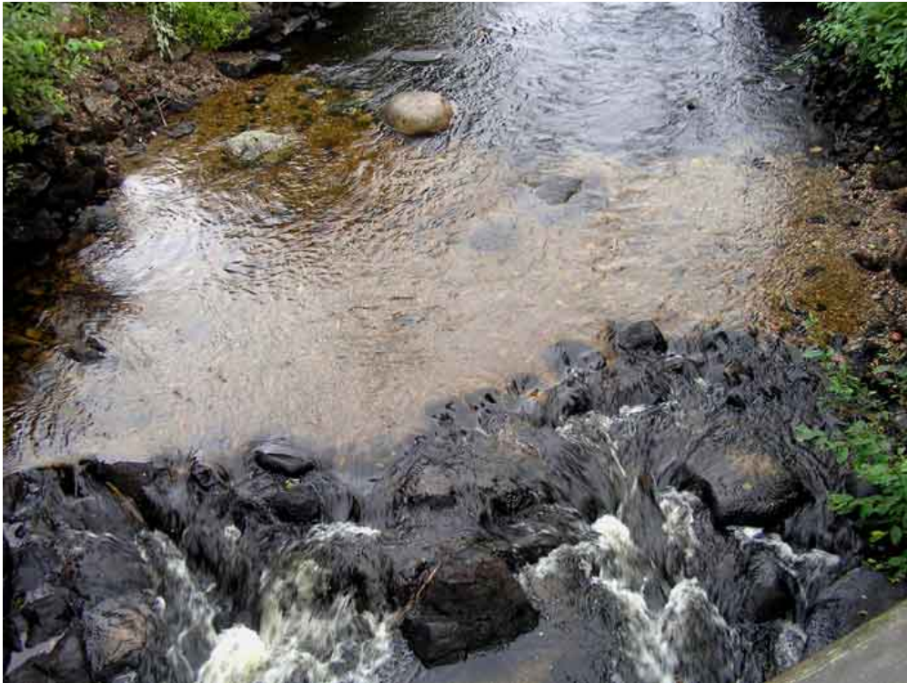
Figur 175. Lekbotten i Rastälven, Örebro län vid Grängshyttan, anlagd bakom en låg tröskel. Vattnet strömmar nedåt i bilden. Notera att själva lekbotten har en blandning av substrat även om fina fraktioner dominerar. Efter vårflod försvann en stor del av substratet därför att det var för stor andel rundat (svallat) grus utan tillräckligt inslag av större sten. Foto: Erik Degerman.
