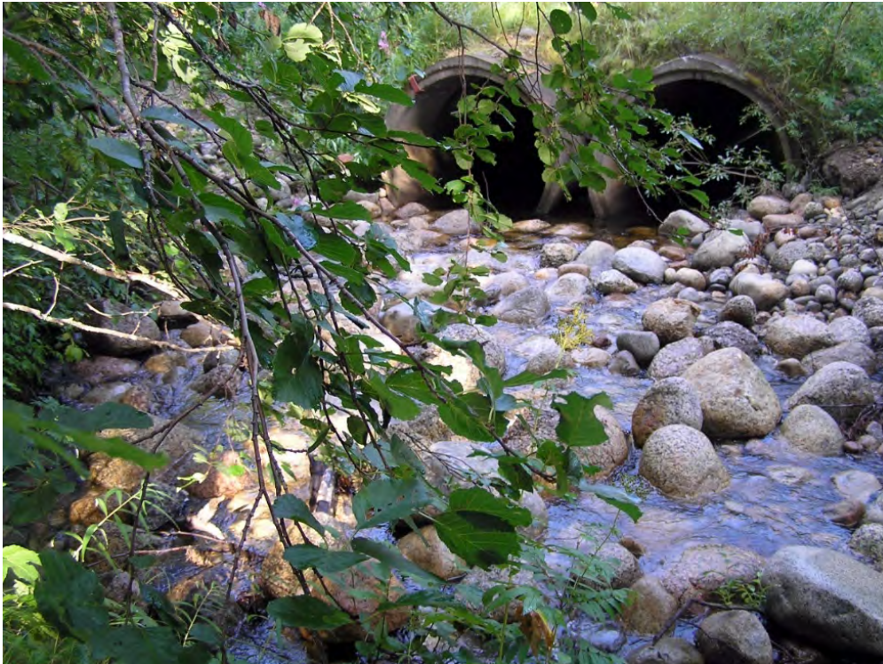
Figur 132. Tröskling nedströms vägtrumma för att minska vattenhastigheten och få nedströms vatten att direkt ansluta till trumman utan fall. Vid låg vattenföring, som på bilden, blir dock en tröskel nedströms ett hinder för större fiskars passage om inte en tydlig fåra skapas. Foto: Erik Degerman.
