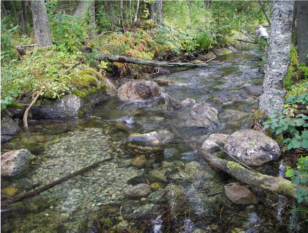
Figur 158. Anlagd forsacke med leksubstrat uppströms nacken, som samtidigt inte gjorts för tät utan även medger fiskvandring vid lägre flöde. Död ved har placerats ut på ett naturligt sätt. Foto: Gunnar Jacobsson.
