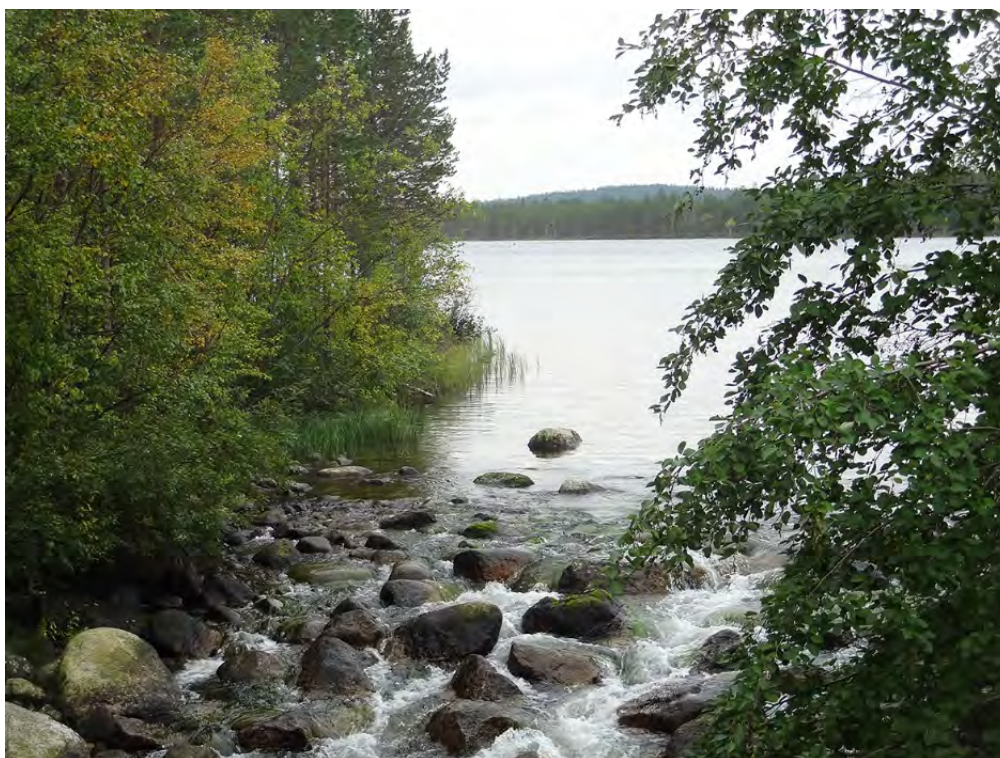
Figur 113. Enkelt ordnat dämme av sten i ett mindre sjöutlopp istället för en tidigare låg damm. Foto: Erik Degerman.
