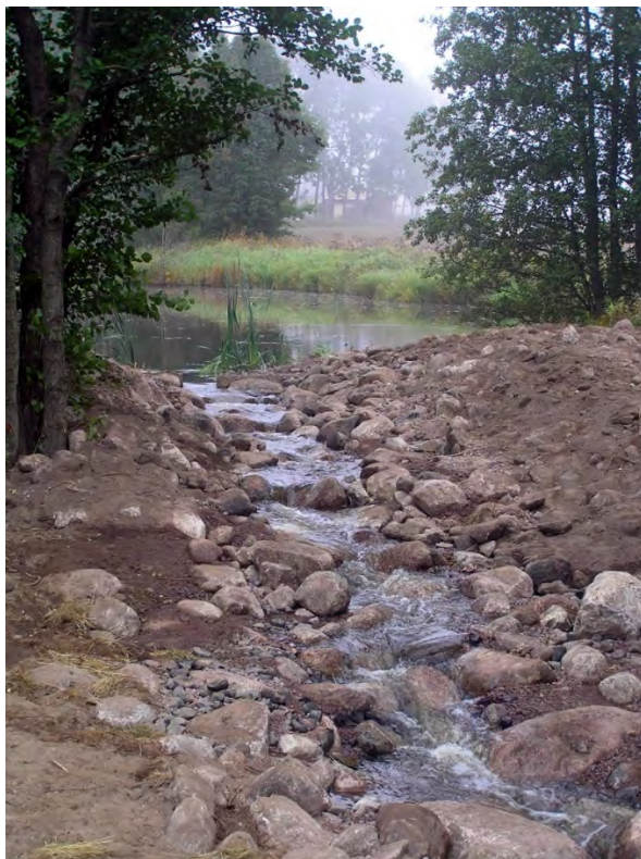
Figur 117. Ramp eller som det också kallas upptröskling som ersatt ett lågt dämme i Sjörydsbäcken, Hjo kommun. Bottenprofilen är v-formad för att fungera såväl vid låg som hög vattenföring. Fotot är taget under konstruktion varför marktäckte ej är på plats. Foto: Erik Degerman.
