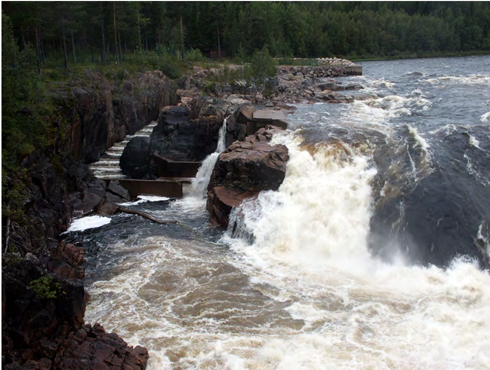
Figur 2. Fiskvägen förbi Jockfall i Kalixälven underlättar för laxen att ta sig uppströms. En kompensation för vattenkraftutbyggnad i andra älvar och ett överfiske till havs. Årligen passerar 5000–15000 laxar uppströms. Foto: Erik Degerman.
