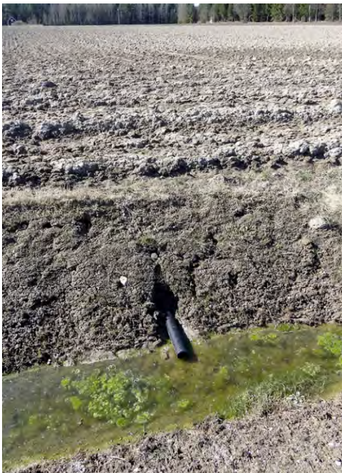
Figur 61. Täckdiken under åkermark resulterar ofta i stora mängder närsalter ut i ytvatten. Foto: Erik Degerman.
