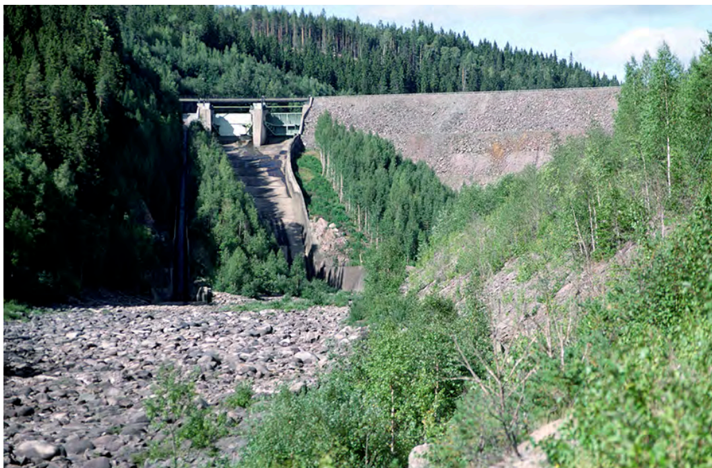
Figur 104. Höljesdammen i övre Klarälven samt del av nedströms torråra. Fallhöjden är 88 m och regleringen i dammen styr mycket av kraftproduktionen i de åtta kraftverken nedströms. Laxen kan inte längre nå upp till de övre delarna av älven (Trysilälven) i Norge. Foto: Erik Degerman.
