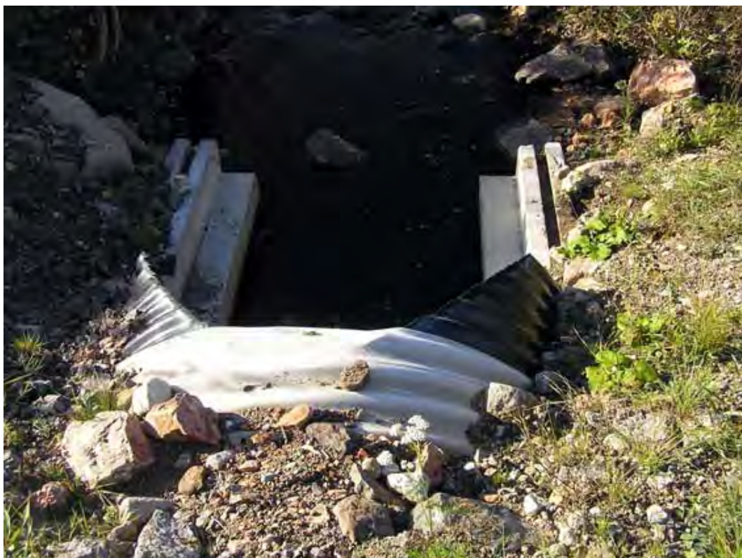
Figur 126. Vy uppifrån över inlopp till halvtrumma på betongfundament. Observera hur fundamenten gjutits med en slits som underlättar inplacering och stabilisering av trumman. Vid behov hade något eller båda fundamenten kunna ha gjutits bredare så att en strandpassage för utter hade bildats. Den uppmärksamme läsaren kan ana från vattendragets bredd att trumman tyvärr är underdimensionerad – som så ofta. Foto: Erik Degerman.
