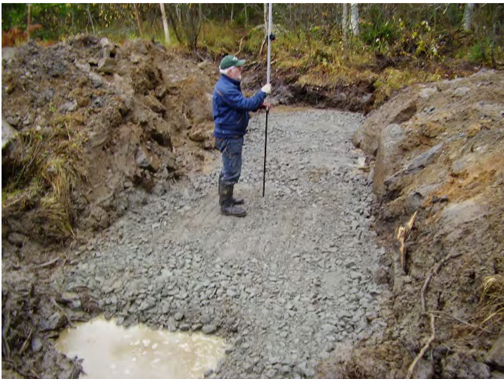
Figur 128. Här har underlaget (stenskross) under vägtrumman kommit på plats och kompakterats. Genom avvägning ser man att det blir rätt lutning (Skärjån, Söderhamns kommun). Foto: Jan Lundstedt.
