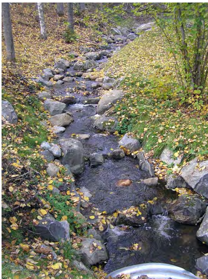
Figur 120. Omlöp förbi stendammen i Sunnäsbruk, Tvärån i Söderhamns kommun. Byggt år 2005. Dammen är en rest av ett gammalt järnbruk och har stort kulturellt värde, varför den bevarades orörd. Vy uppströms. I bildens nederdel syns övre delen av vägtrumma för passage under en bilväg. Lutningen är hela 5% men de flesta arter bedöms kunna vandra tack vare de små trappsteg som anlagts. Foto: Erik Degerman.
