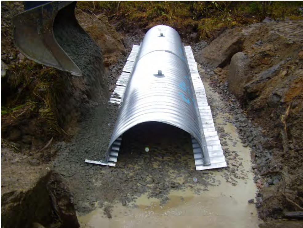
Figur 127. Enkla stöd i form av korrugerad stålplåt används när trumman inte ska bära tyngre trafik. Foto: Jan Lundstedt.
