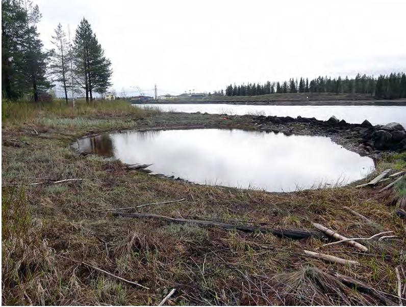
Figur 100. En liten avsnörd "refugdamm", eller "damm i damm" som det också kallas, har skapats i Kilforsen, Fjällsjöälven. Från vänster kommer ett surdråg ned och försörjer den lilla dammen med nytt vatten. Tillsammans med dämmet ut mot regleringsmagasinet gör detta att det håller vatten även vid låga vattennivåer. Från Strömberg m fl 2018. Foto: Erik Degerman.
