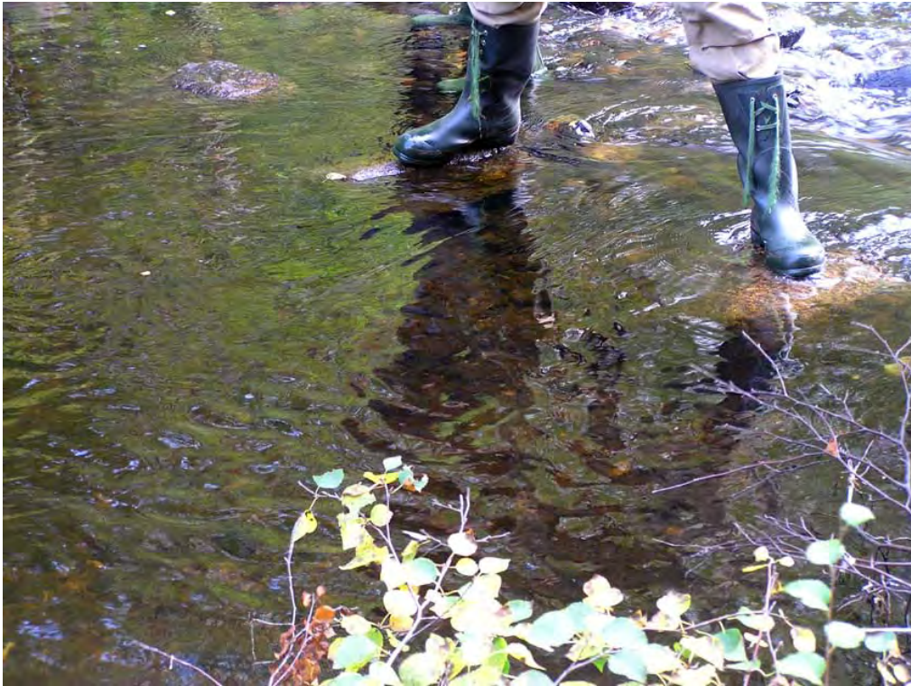
Figur 171. Lekbotten färdigställd. Personen står på de större stenarna som lagts nedströms för att kvarhålla leksubstratet. Dessa stenar läggs i en gles hästskoform nedströms och utmed sidorna. Ibland kan man behöva styra in vatten över lekbotten med hjälp av större sten uppströms. Se till att lekbotten inte ligger så högt att den kan bottenfrysa vintertid. Foto: Erik Degerman.
