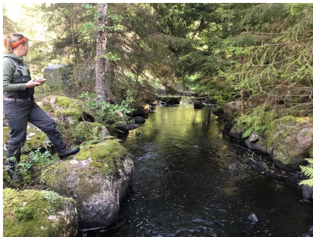
Figur 27. Rensad bestämmande sektion. Rensningen har utförts genom att block och sten grävts bort vilket lett till sänkt lokal basnivå. Det första steget vid design av den nya och återställda bestämmande sektionen är att försöka läsa av landskapet. Genom att titta på fåran, rensmassorna och omgivningen går det att bedöma på ett ungefär hur det borde sett ut från början, hur sten och block skulle kunna placeras ut och vilken effekt en sådan åtgärd kan tänkas få på områdena uppströms. Foto: Mathias Ibbe.
