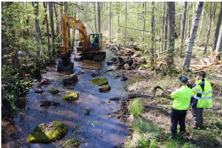
Figur 13: Förr eller senare är det dags för själva åtgärderna. Här återställs en B-sträcka som i dess uppströmsdel ska fungera som bestämmande sektion. Återställningen kommer innebära att basnivån återställs för sträckorna uppströms. Foto: Lars Gezelius.
