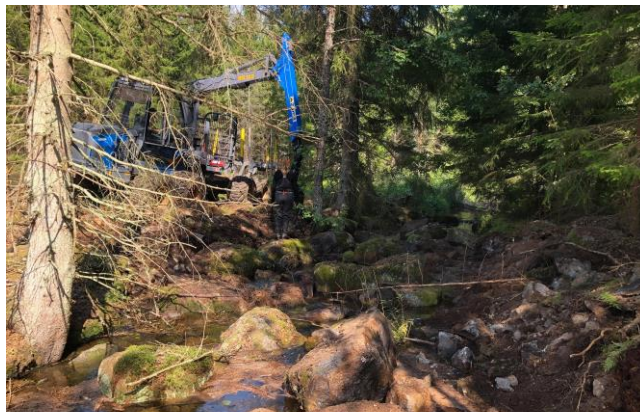
Figur 29. Återställning av bestämmande sektion pågår. Foto: Mathias Ibbe.
