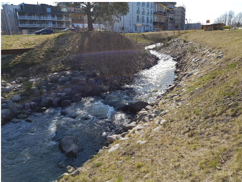
Figur 110. Bilderna visar en B-sträcka som i första hand utformats som en B1-sträcka (trappstegsformat vattendrag) som ska överbrygga höjdskillnaden mellan två delsträckor. Fotona är från samma exempel som beskrevs som terrängmodell och profil i föregående bild. Övre foto taget i samband med byggnation, det nedre lite mer än 5 år senare. Foto: Peter Gustafsson, Streams & Lakes Consulting AB.
