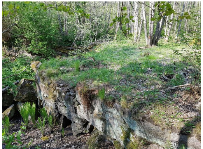
Figur 81. Damm med stora mängder sediment som når ända upp till dammkrönet. Någonstans under sedimenten finns de ursprungliga svämplanen och den ursprungliga fåran. Foto: Peter Gustafsson, Streams & Lakes Consulting AB.
