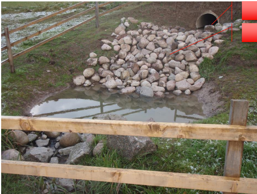
Figur 103. Exempel på droppstruktur vid ett brant kulverterat vattendrags sammanflöde med en huvudfåra. Detta vattendrag hade en brant lutning vilket resulterade i erosion (underminering) inne i kulverten samt att det skedde omfattande erosion vid kulvertens mynning i en huvudfåra (fotot är taget från huvudfåran). De två lösa ringarna visar hur stor del av slänten som försvunnit via erosionen. Problemet löstes med en droppstruktur i natursten. Nu tas lutningen ut vid droppstrukturen och inne i kulverten är lutningen lägre vilket ger större stabilitet. Foto: Peter Gustafsson, Streams & Lakes Consulting AB.
