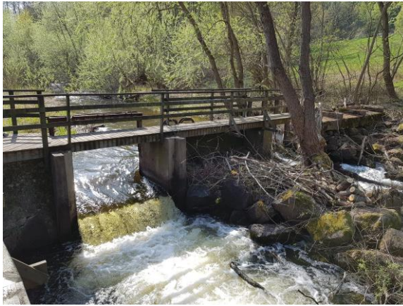
Figur 79. Exempel på en damm som är avsänkt men fortfarande dämmer något. Om den ska rivas helt gäller det att kika igenom block och sten som finns på plats och försöka bedöma hur hög tröskel i grovt material som legat här tidigare, det vill säga på vilken elevation basnivån som ska återställas ska ha. Foto: Peter Gustafsson, Streams & Lakes Consulting AB.
