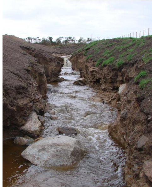
Figur 107. Fotona visar en delsträcka med en nyskapad fåra som har fått en för hög lutning. Den höga lutningen leder till en instabilitet. Fåran ligger mitt emellan två andra delsträckor som har lägre lutning.
