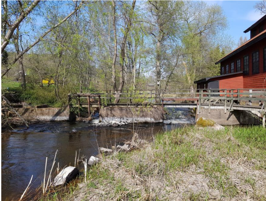
Figur 80. Exempel på damm som byggts i anslutning till en bestämmande sektion och där det bland annat finns betongkonstruktioner, rester av ett kraftverk och en industri. Den omfattande påverkan försvårar arbetet med att läsa av hur bestämmande sektioner sett ut. Foto: Peter Gustafsson, Streams & Lakes Consulting AB.
