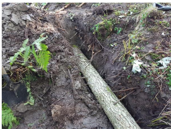
Figur 72. Exempel på delsträcka där stockar grävts ned tvärs över hela svämplanet. Övre bild är efter åtgärd. Om stocken grävs ned över svämplanet minskar risken att fåran förskjuts lateralt och smiter förbi stocken. Foto: Peter Gustafsson, Streams & Lakes Consulting AB.
