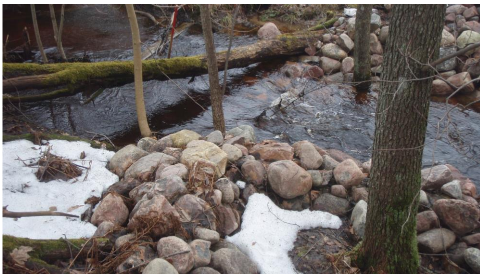
Figur 104. Exempel på droppstruktur utformad som en låg tröskel följt av en flack strömsträcka. Denna har som syfte att kompensera för en något sänkt vattennivå strax nedströms. Den nivå-sänkningen beror på att en meandrande delsträcka har kanalisrats vid en passage under en väg. Fallhöjden vid droppstrukturen ska motsvara hur mycket vattnet har sjunkit i och med den kanaliseringen. Strukturen är stensatt minst upp till 0.3 meter ovanför nivån vid dimensionerande flöde, det är extra viktigt längst upp vid krönet. Foto: Peter Gustafsson, Streams & Lakes Consulting AB.
