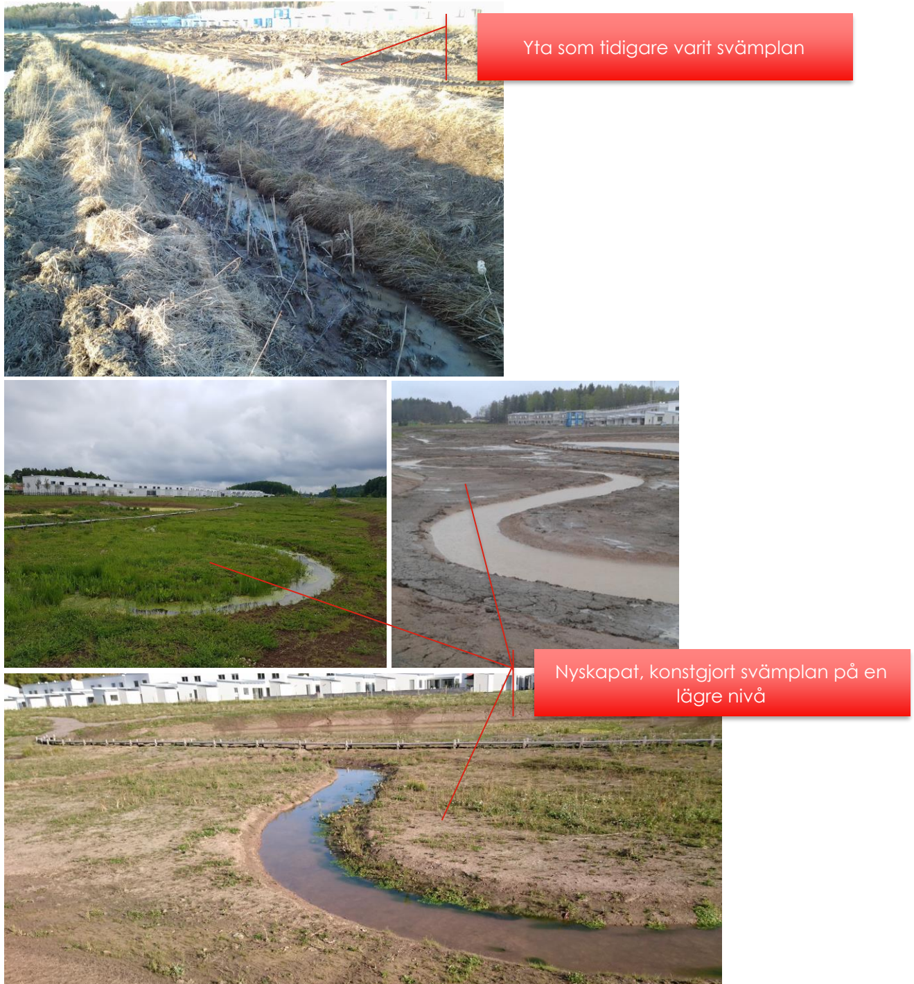
Figur 85. Exempel på artificiella svämplan. Översta bilden visar diket innan åtgärd. Marken kring diket utgör recent terrass. Övriga bilder visar ett artificiellt svämplan som skapats på lägre nivå än det ursprungliga. Genom det nya svämplanet har en ny meandrande fåra grävts. Foto: Peter Gustafsson, Streams & Lakes Consulting AB.
