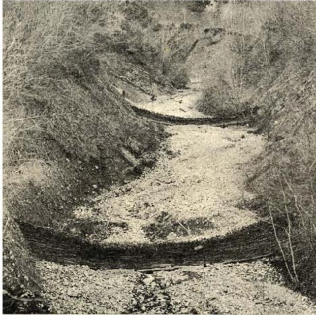
Figur 100. Exempel på strukturer som sannolikt använts som droppstrukturer. Dessa tar ut fallhöjden och därmed energin lokalt och minskar lutningen mellan dem. Foto från 1886.
