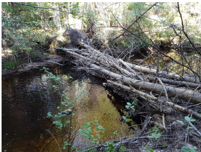
Figur 65. Ett par exempel på bröten som skapar bestämmande sektioner vid högre flöden, men utan dämmande effekt vid låga flöden. Foto: Peter Gustafsson, Streams & Lakes Consulting AB.
