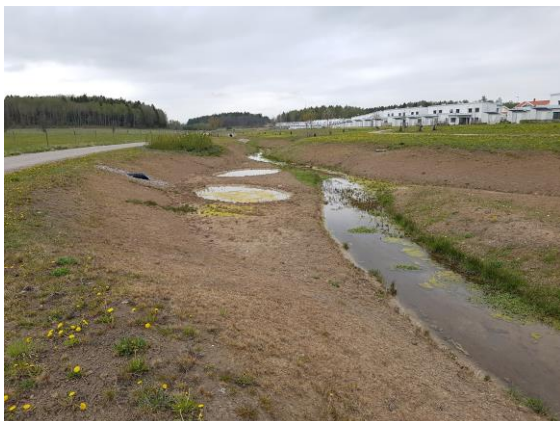
Figur 89. Exempel på artificiella korvsjöar som skapats inom artificiella svämplan. I detta fall är korvsjöarna utformade som små dammar i det artificiella svämplanet. Foto: Peter Gustafsson, Streams & Lakes Consulting AB.
