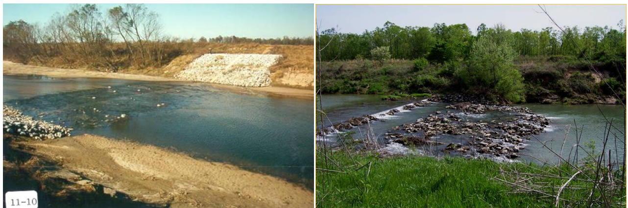
Figur 98. Exempel på permanentering av basnivå. Vänster bild visar en sektion där en tröskel har grävts ned tillsammans med sten och block. Vattendraget är ett C-vattendrag och tröskeln ligger på samma nivå som botten och dämmer därmed ingenting. Syftet är att om en knickpoint börjar vandra upp ska den stanna vid den punkten och basnivån uppströms ska därmed inte kunna sjunka samtidigt som knickpointen bromsas upp. Höger bild visar situationen ca 20 år senare. En eller flera knickpoints har då vandrat upp till tröskeln som då har aktiverats och den fungerar nu som en bestämmande sektion som gör att basnivån uppströms bibehålls. Foto: Dave Derrick.
