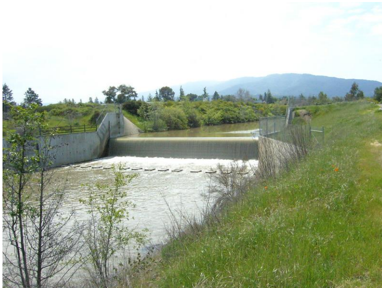
Figur 106. Fotot visar exempel ett exempel på en droppstruktur som är utformad som en betongstruktur. I naturvårdssammanhang bör de designas mer naturligt än vad som är fallet här och denna visas i första hand som ett exempel som ofta träffas på. Denna fungerar såklart också som vandringshinder. Credit: "A Drop Structure." by fainer is licensed with CC BY-NC-SA 2.0. To view a copy of this license, visit https://creativecommons.org/licenses/by-nc-sa/2.0/
