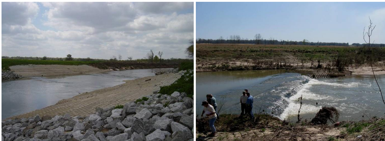
Figur 99. Exempel på permanentering av basnivå. Vänster bild visar en sektion med en erosionsmatta som sträcker sig från ena slänten till den andra. Syftet är att om en knickpoint börjar vandra upp ska den stanna vid den punkten och basnivån uppströms ska därmed inte kunna sjunka samtidigt som knickpointen bromsas upp. I detta fall var det också infrastruktur som skulle skyddas. Höger bild visar situationen ca 5 år senare. En knickpoint har då vandrat upp och erosionsmattan har aktiverats och lyckats bromsa knickpointen. Foto: Dave Derrick.
