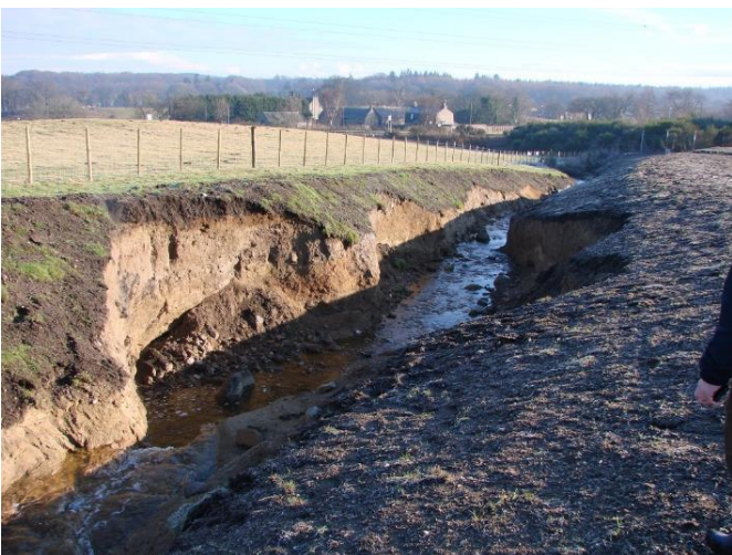
Figur 107. Fotona visar en delsträcka med en nyskapad fåra som har fått en för hög lutning. Den höga lutningen leder till en instabilitet. Fåran ligger mitt emellan två andra delsträckor som har lägre lutning.
