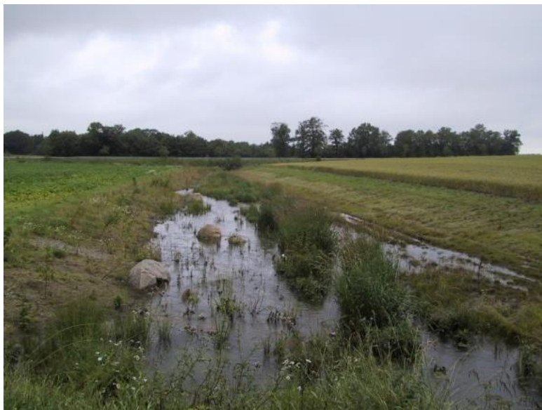
Figur 87. Exempel på tvåstegsdiken. På nedre bild är det högflöde och både fåran och den skapade översvämningsytan står under vatten. Foto: Indiana Watershed Initiative respektive Miljöförbundet i Helsingborg.
