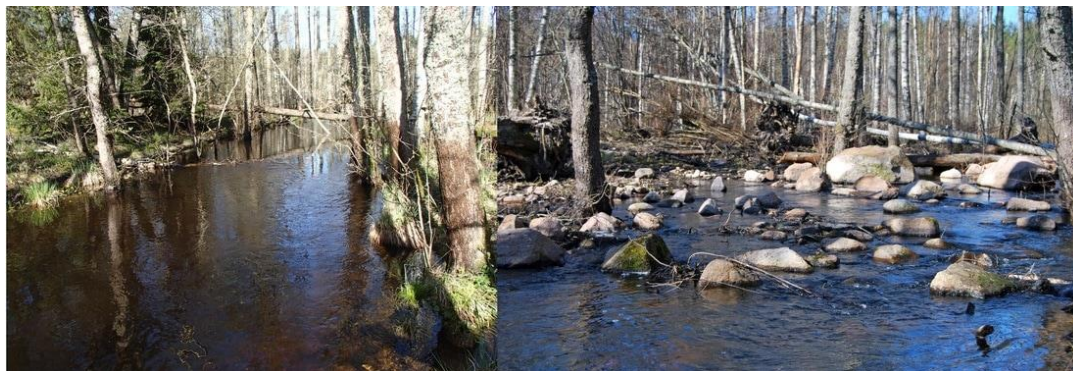
Figur 26. Figuren visar en rensad bestämmande sektion före respektive efter åtgärd. Den bestämmande sektionen har återställts genom att upprensade block och stenar placerats tillbaka i fåran. Foto: Mathias Ibbe.
