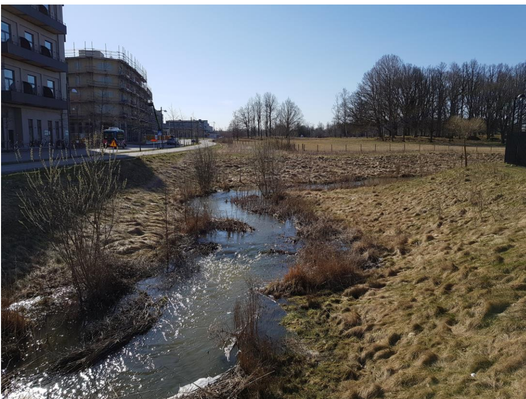
Figur 95. Exempel på konstgjord C-sträckta med växels hölja och strömsträckta (riffle-pool). Här har grövre material än grus valts för att tillförseln av material är obefintlig (jordarten är ler) och för att öka stabiliteten. Övre fotot är taget ganska nära inpå byggnation och vid ovanligt lågt flöde, det andra är taget 5 år senare. Foto: Peter Gustafsson, Streams & Lakes Consulting AB.
