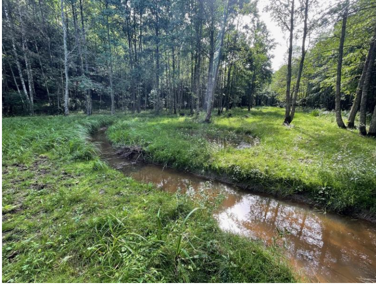
Figur 40. Exempel på sträcka i skogsmiljö där basnivån och fåran återskapats. Här ska skogen utvecklas fritt och det har antagits att det kan uppstå en morfologi som styrs av död ved samt en anastomerande planform över tid. I anläggningskedet skapades dock en meandrande singelfåra av kostnadsskäl. Foto: Per Saarinen
