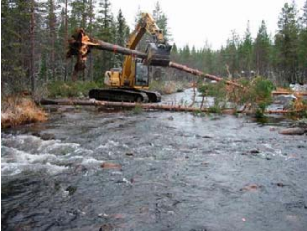
Grävmaskiner kan också användas för att tillföra död ved. Det kan vara svårare att ta sig fram med en sådan maskin jämfört med en skotare, men risken för markskador blir mindre. Bilden visar iläggning av stockar i Abmobäcken, ett biflöde till Vindelälven. Foto: Niclas Hjerdt.
