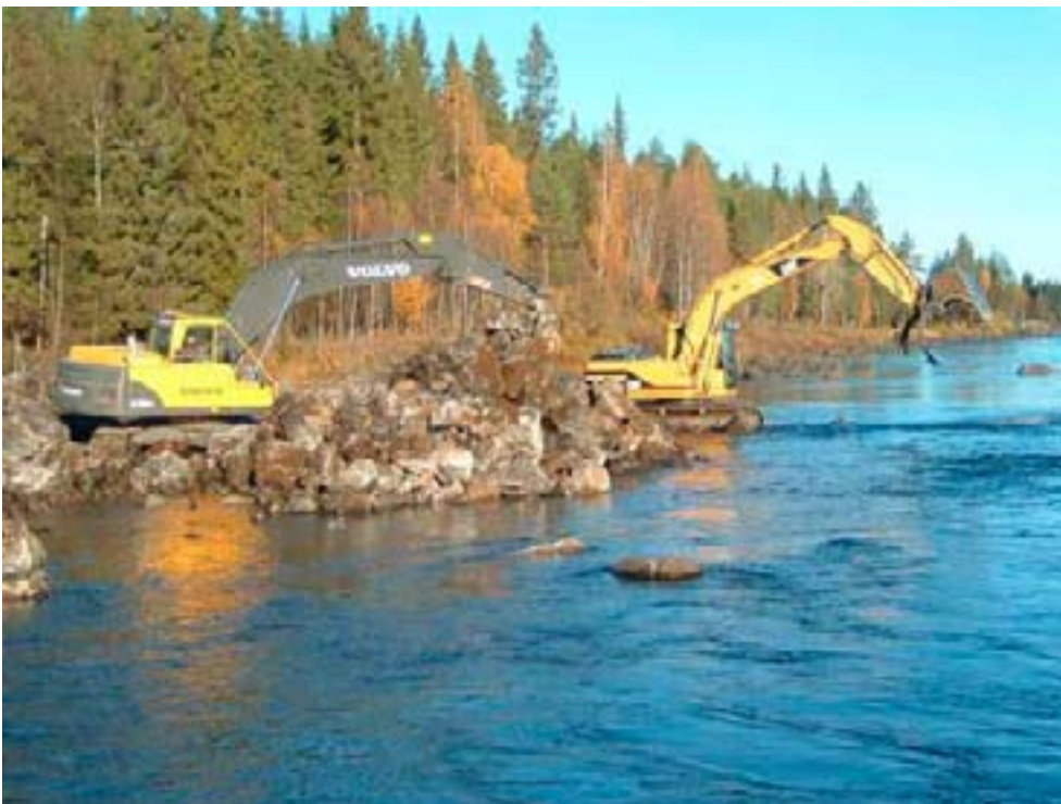
Återställningsarbete vid Kittelforsen i Vindelälven. Två maskiner arbetar tillsammans eftersom materialet måste flyttas en bit innan det kan läggas ut i älven. Den ena maskinen har en gripskopa som fungerar mycket bra vid älvestaurering, särskilt när man hanterar grova block. Foto: Daniel Holmqvist.
