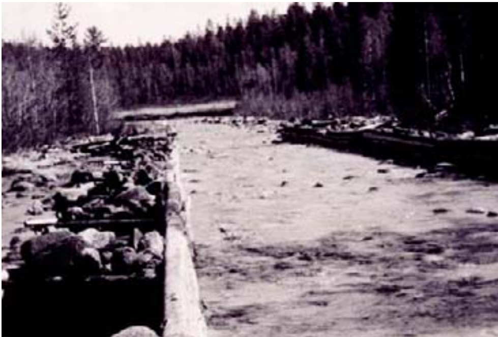
Om vattendragen var krokiga eller hade flacka stränder där timret lätt kunde fastna kanaliseras de med hjälp av stenkistor. Ovan enkelkista. Foto: Handbok i Skogsteknologi (Löf och G. Kinnman), Stockholm 1922 (fotograf okänd). Se också foto på följande sida.
