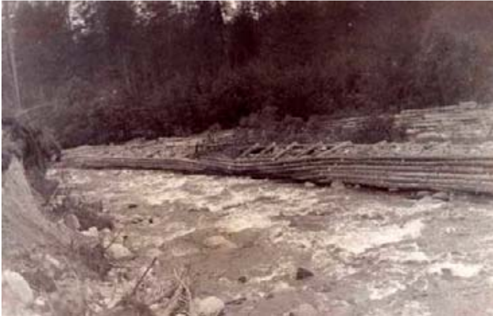
Ytterligare exempel på kanalisering. Dubbelkista. Foto: Umeå flottningsförenings arkiv, Folkhälso- searkivet vid Västerbottens museum, Umeå (fotograf okänd).
