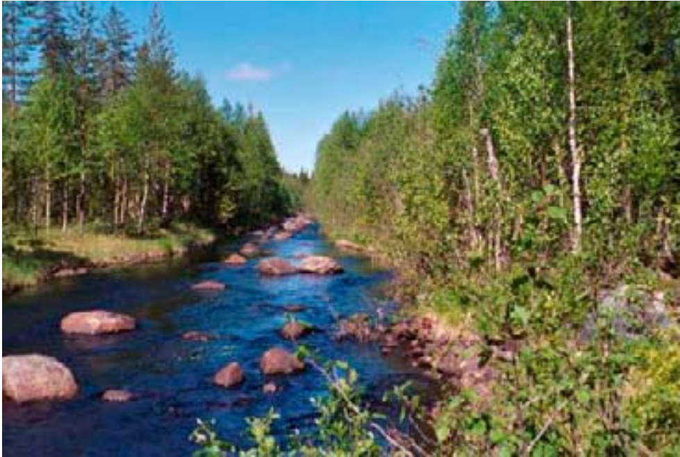
Foto över mindre lyckad restaurering. Troligen har arbetet genomförts vid högvatten eftersom de flesta större stenar ligger löst på underliggande substrat. All sten av samma storleksklass är dessutom lagd i mitten av bäcken, något som ger ett onaturligt utseende. Foto: Robert Ström.
