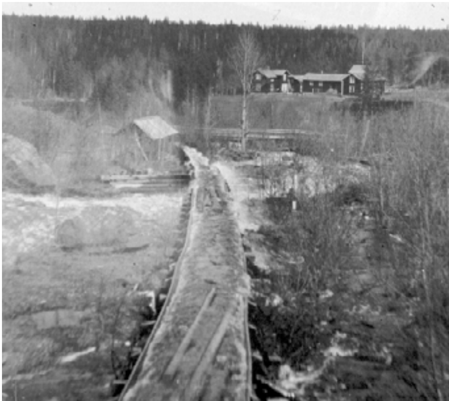
Timherrännan var ett praktiskt sätt att flytta timret förbi besvärliga forsar. Betydelsen av timherrännor omtalas i den första och länge enda tekniska handboken i flottledsbyggnad: "Handledning vid flottningar och strömbyggnader", av C H Carlgren från 1885. Här kan man läsa att "stenrensning hafva i allmänhet användts allt för frikostigt i våra flottleder i stället för rännor, hvilka de aldrig kunna ersätta, om strömmen är stark och krokig samt vattentillgången ringa". Och: "lyckas man äfven få bottnen tämligen jemn, inträffar vid lågvatten ändå timmerfästen, som med möda och risk för menniskolif måste lossas". Foto från 1922, Umeå flottningsförenings arkiv, Folkrorelsearkivet vid Västerbottens museum, Umeå (fotograf okänd).
