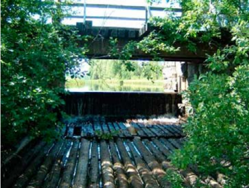
Många flottningsstrukturer är ännu i gott skick. Bilden visar Rotenträskdammens intakta slussgolv och flottningsdamm. Den ligger i Sikbäckens vattensystem i Vindelälvsystemet. Foto: Daniel Jonsson.
