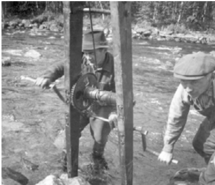
Många flottare arbetade under lågvattenperioden på hösten med att förbättra flottleden. Bilden visar manuell stenrensning med så kallad lyftknekt. Foto: Umeå flottningsförenings arkiv, Folkrorelsearkivet vid Västerbottens museum, Umeå (fotograf okänd).
