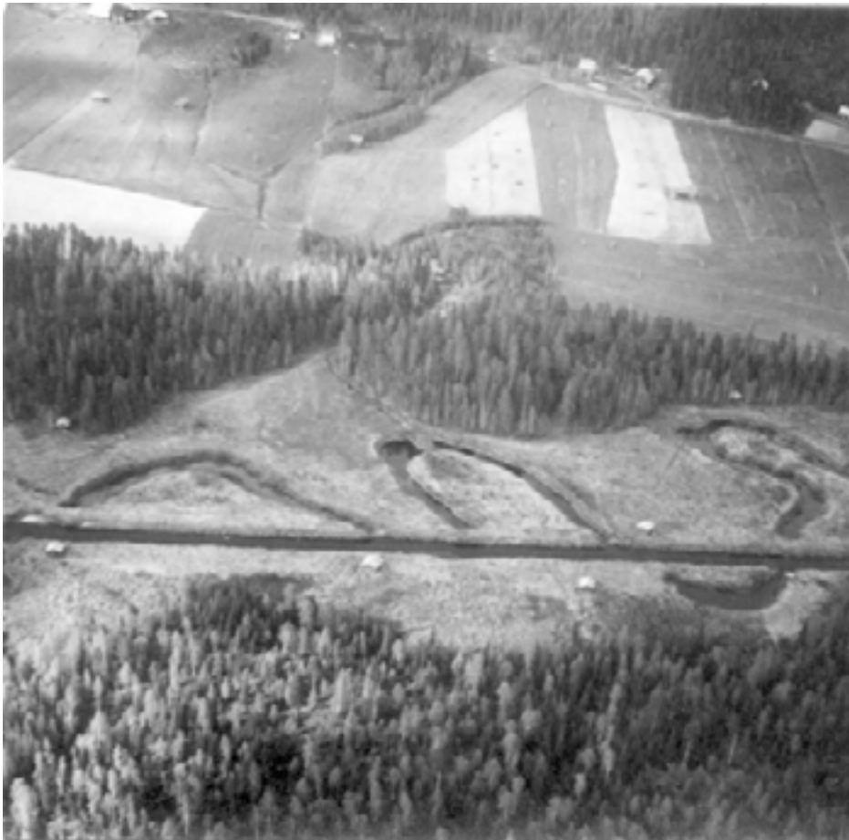
Om marken var lättgrävd och vattendraget mycket krokigt kunde man gräva en helt ny fåra. Bilderna ovan och på följande sida visar två sådana kanaliseringar. Ovan: Flygbild över bivattendrag till Öre älv.
