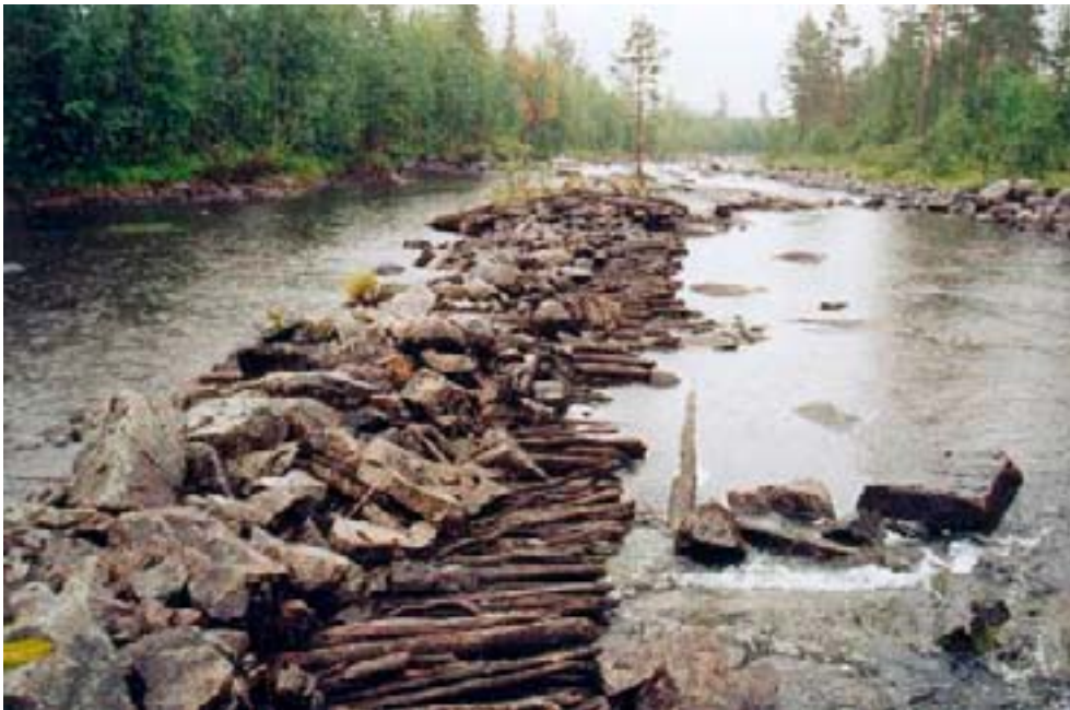
Riskista, Olsbäcken. Riskistan består av en bädd av klena trädstammar på vilken en stenbarriär uppfördes. Detta var ett praktiskt sätt att kanalisera eftersom det gick fort och smidigt att risa och man slapp mycket tungt stenarbete. Foto: Erik Törnlund.
