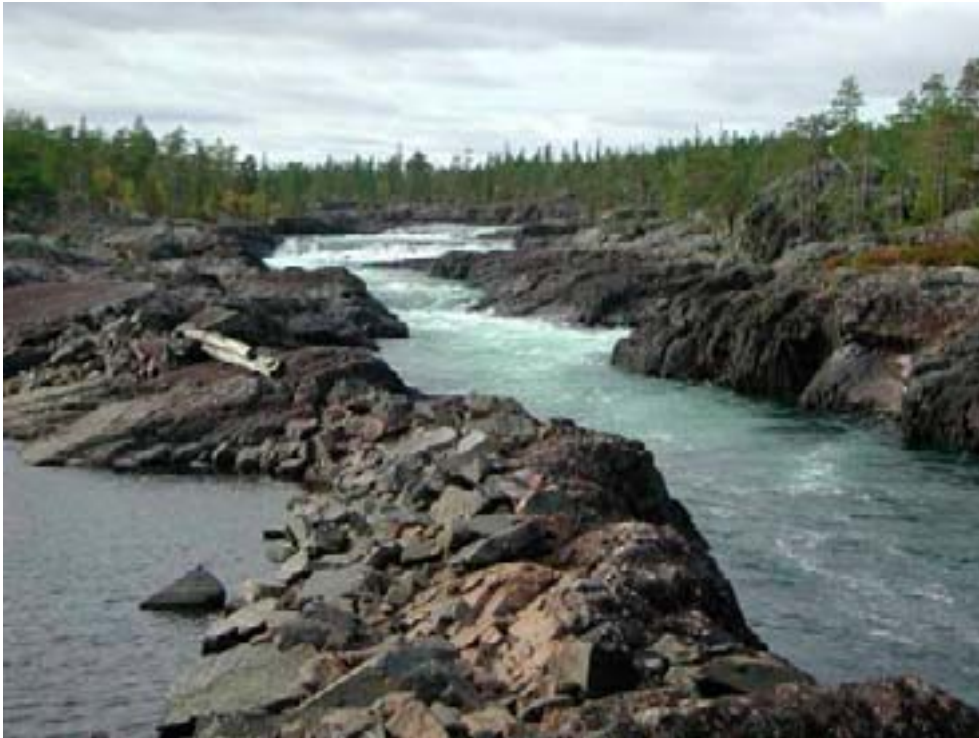
Sprängd flottningskanal genom berget vid Trollforsen i Piteälven. Älven rann ursprungligen i två fåror över en slipad berggrund. Den ena fåran hölls avstängd under flottningen och i den andra sprängdes denna kanal. Numera hålls bägge fårorna öppna men kanalen är exempel på en struktur som är svår att ta bort. Foto: Christer Nilsson.
