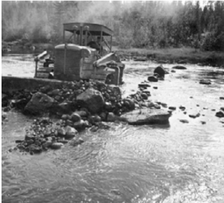
Traktorrensning av vattendrag. Denna metod användes flitigt från 1950-talet och framåt. Många forsar fick sina bottnar utschaktade under denna tid – några år senare upphörde flottningen. Foto: Umeå flottningsförenings arkiv, Folkrorelsearkivet vid Västerbottens museum, Umeå (fotograf okänd).
