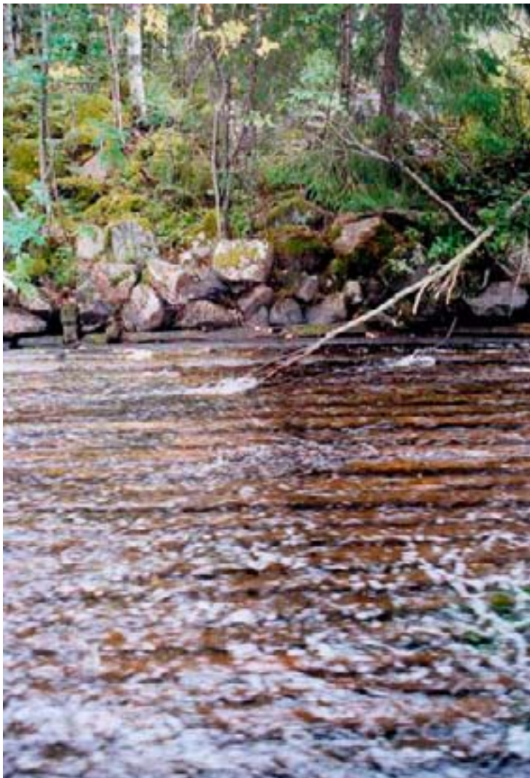
Skibord, Arvån. Skibordet är ett golv av parallella stockar som hindrar timret från att fastna på botten. Denna konstruktion är vanlig i anslutning till dammar. Foto: Erik Törnlund.
