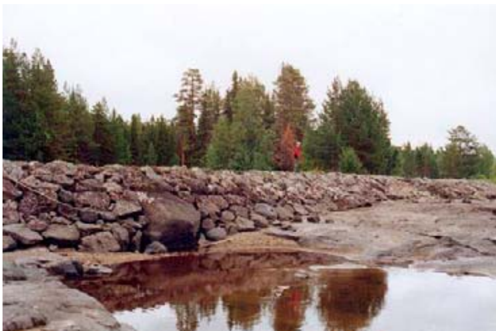
Rösmur. Till rösmuren användes natursten som passades ihop till en tät mur. Foto: Erik Törnlund.
