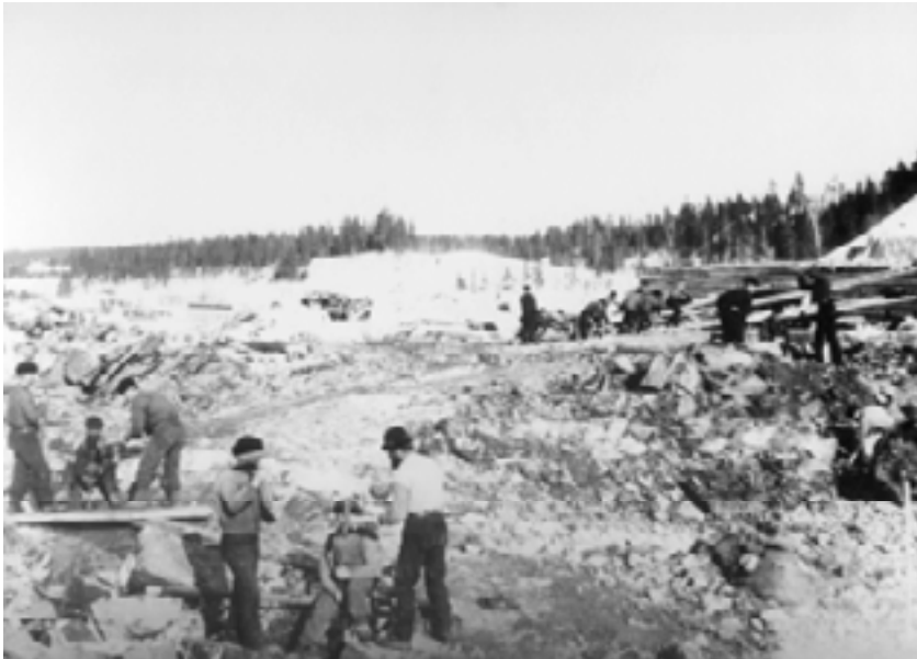
Stensprängning och byggande av dubbel tråkista. Degerforsen i Vindelälvens huvudfåra vid början på 1900-talet. Foto: Degerfors byamäns arkiv vid Vindelns kommun (fotograf okänd).
