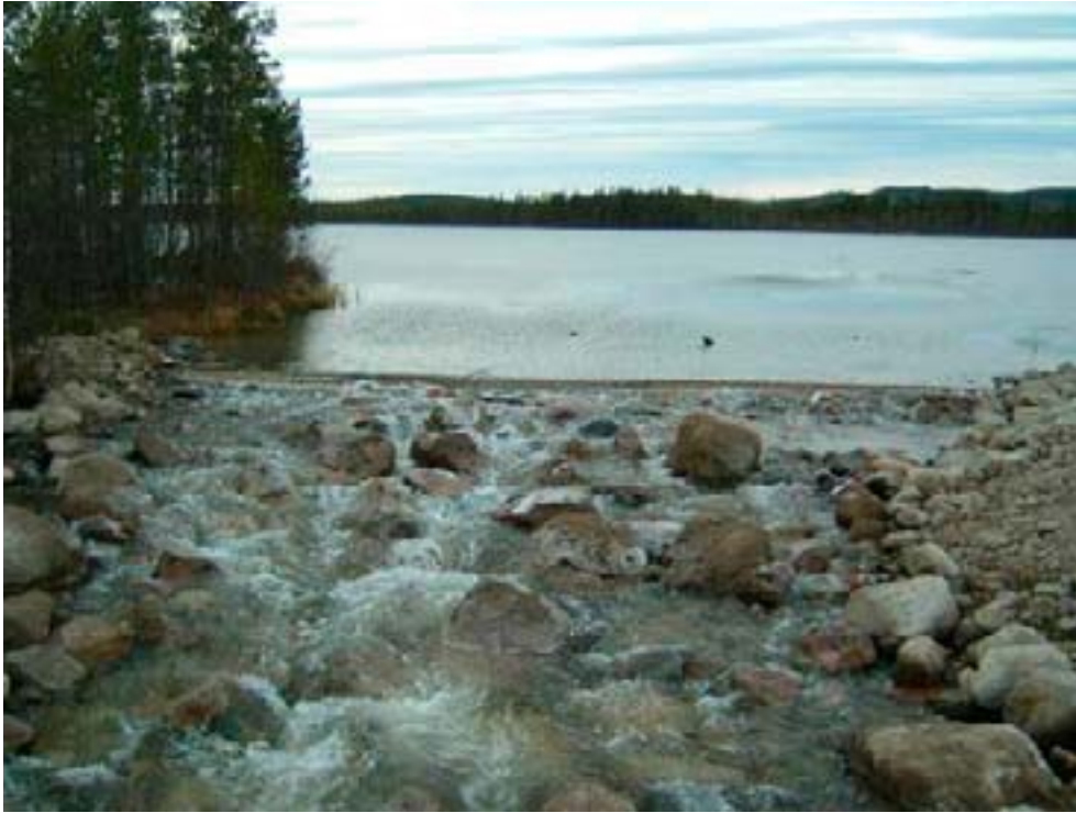
Konstruerad tröskel och återskapad forssträcka efter borttagning av flottningsdamm i Falåströmsbäcken, ett biflöde till Vindelälven. Foto: Daniel Holmqvist.
